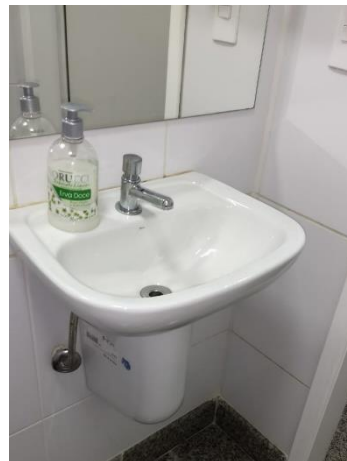
Figura 77 - Banheiro adaptado Fonte: Própria
