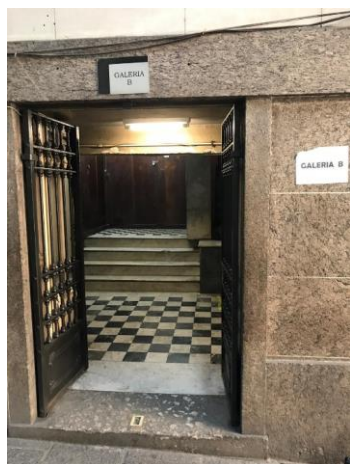
Figura 55 - Acesso galeria B Fonte: Própria
