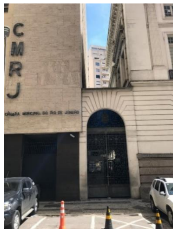
Figura 33 Entrada de serviço Fonte: Própria
