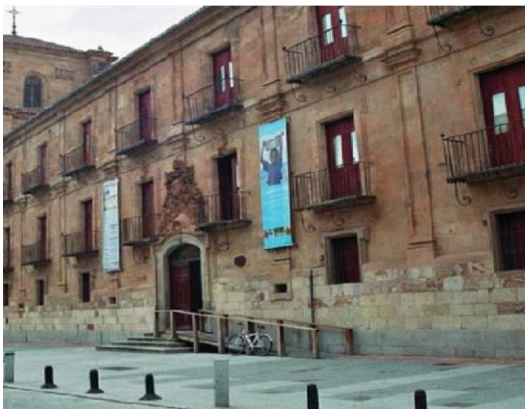
Figura 112 Rampa de acesso na fachada Fonte: ANDRADE, Isabela Fernandes.
