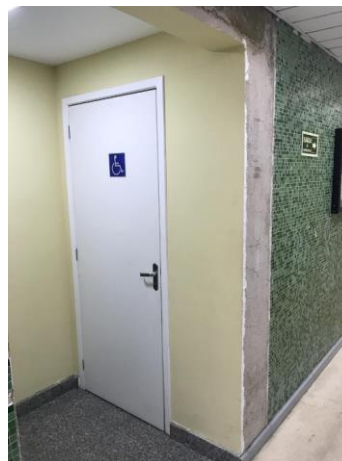
Figura 75 - Porta de acesso ao banheiro Fonte: Própria
