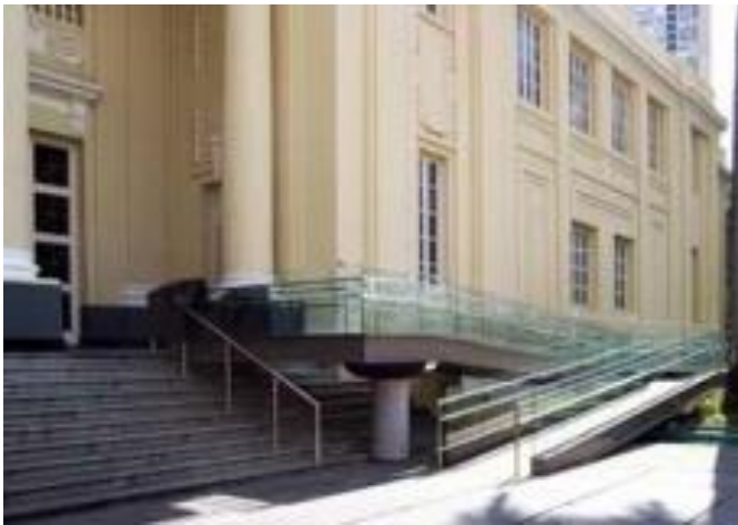
Figura 108 Rampa de acesso instalada na fachada Fonte: ANDRADE, Isabela Fernandes.
