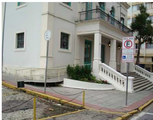
Figura 113 Rampa de acesso na fachada Fonte: ANDRADE, Isabela Fernandes.
