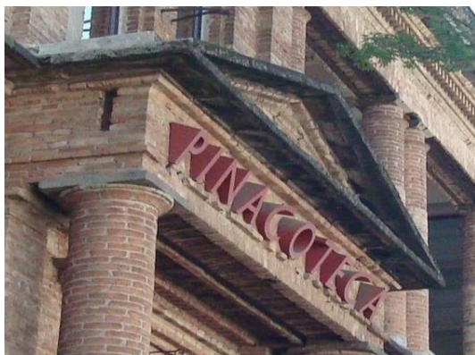
Figura 98 - Letreiro de identificação na fachada Fonte: ANDRADE, Isabela Fernandes.
