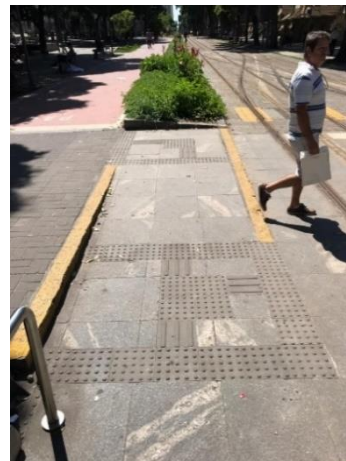
Figura 42 - Plataforma VLT Fonte: Própria
