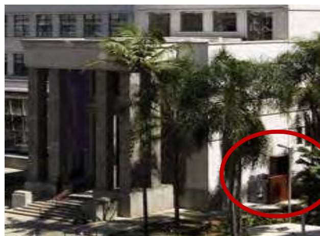
Figura 80 - Vista da Biblioteca Mário de Andrade e detalhe da plataforma na lateral da entrada principal. Fonte: Piratininga Arquitetos Associados.
