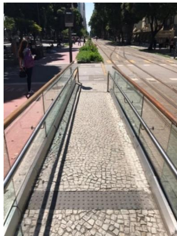
Figura 41 - Plataforma VLT Fonte: Própria
