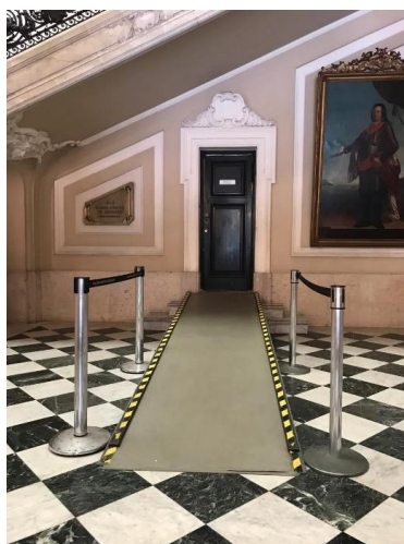
Figura 64 - Rampa de acesso à mesa da presidência Fonte: Própria
