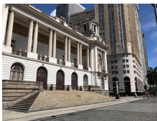
Figura 48 - Escadaria principal do palácio Fonte: Própria
