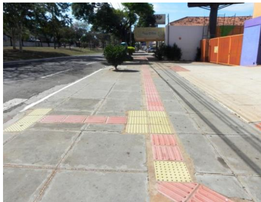
Figura 91 - Piso tátil alerta e direcional Fonte: Própria
