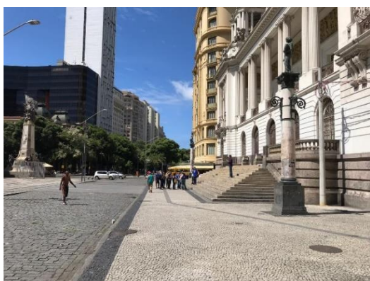
Figura 24 Piso tátil na fachada do palácio Fonte: Própria
