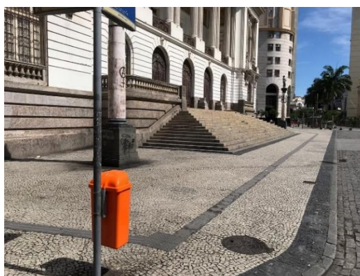
Figura 25 Piso tátil na fachada do palácio Fonte: Própria
