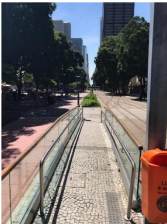
Figura 40 - Plataforma VLT Fonte: Própria
