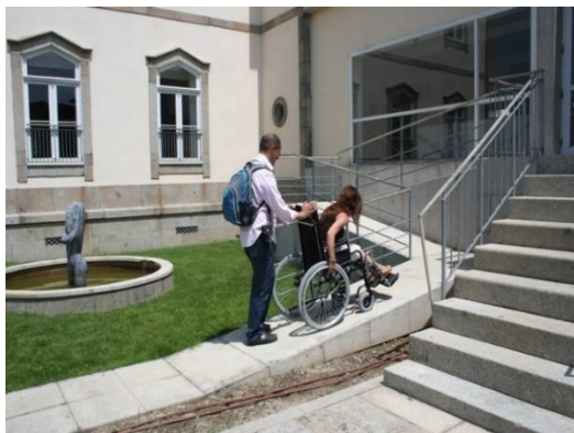
Figura 110 - Rampa de acesso na fachada Fonte: ANDRADE, Isabela Fernandes.
