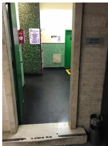
Figura 58 - Acesso escadas Fonte: Própria
