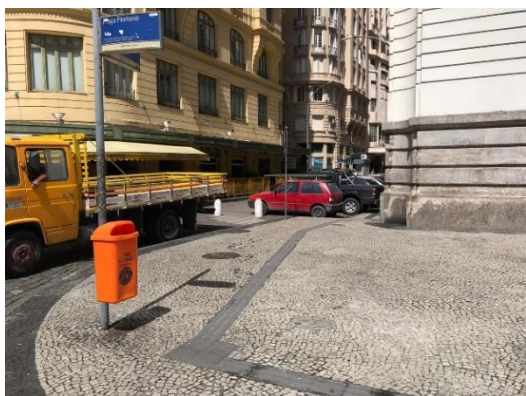
Figura 26 Piso tátil na fachada do palácio Fonte: Própria
