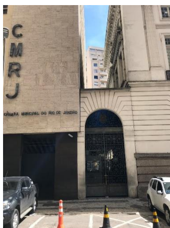
Figura 51 - Entrada de serviço Fonte: Própria
