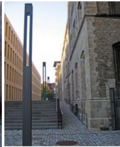
Figura 109 Rampa de acesso Fonte: ANDRADE, Isabela Fernandes.
