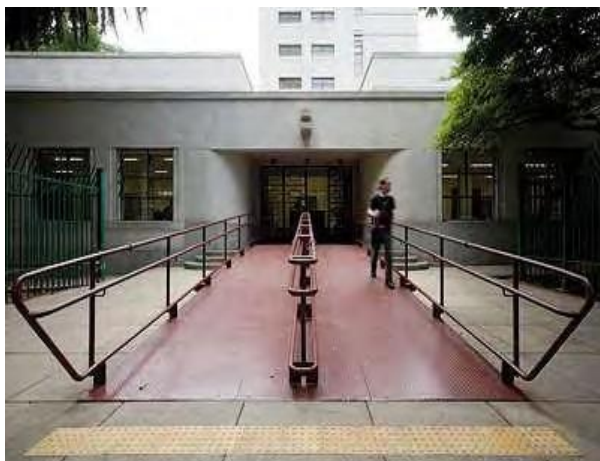
Figura 81 - Entrada da Biblioteca pela Av. São Luís. Fonte: Maíra Acayaba/Revista AU.
