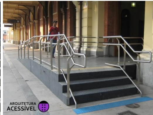
Figura 111 - Rampa de acesso na fachada Fonte: ANDRADE, Isabela Fernandes.
