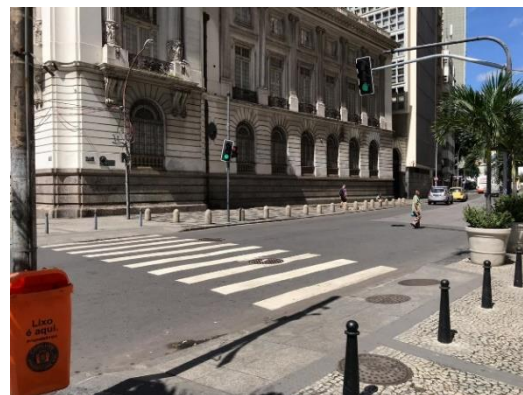
Figura 21 - Rebaixamento do meio fio Fonte: Própria
