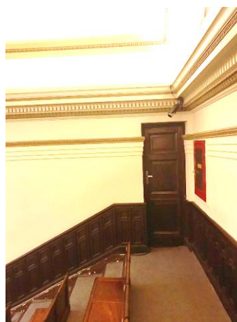
Figura 73 - Parte interna da galeria A Fonte: Própria
